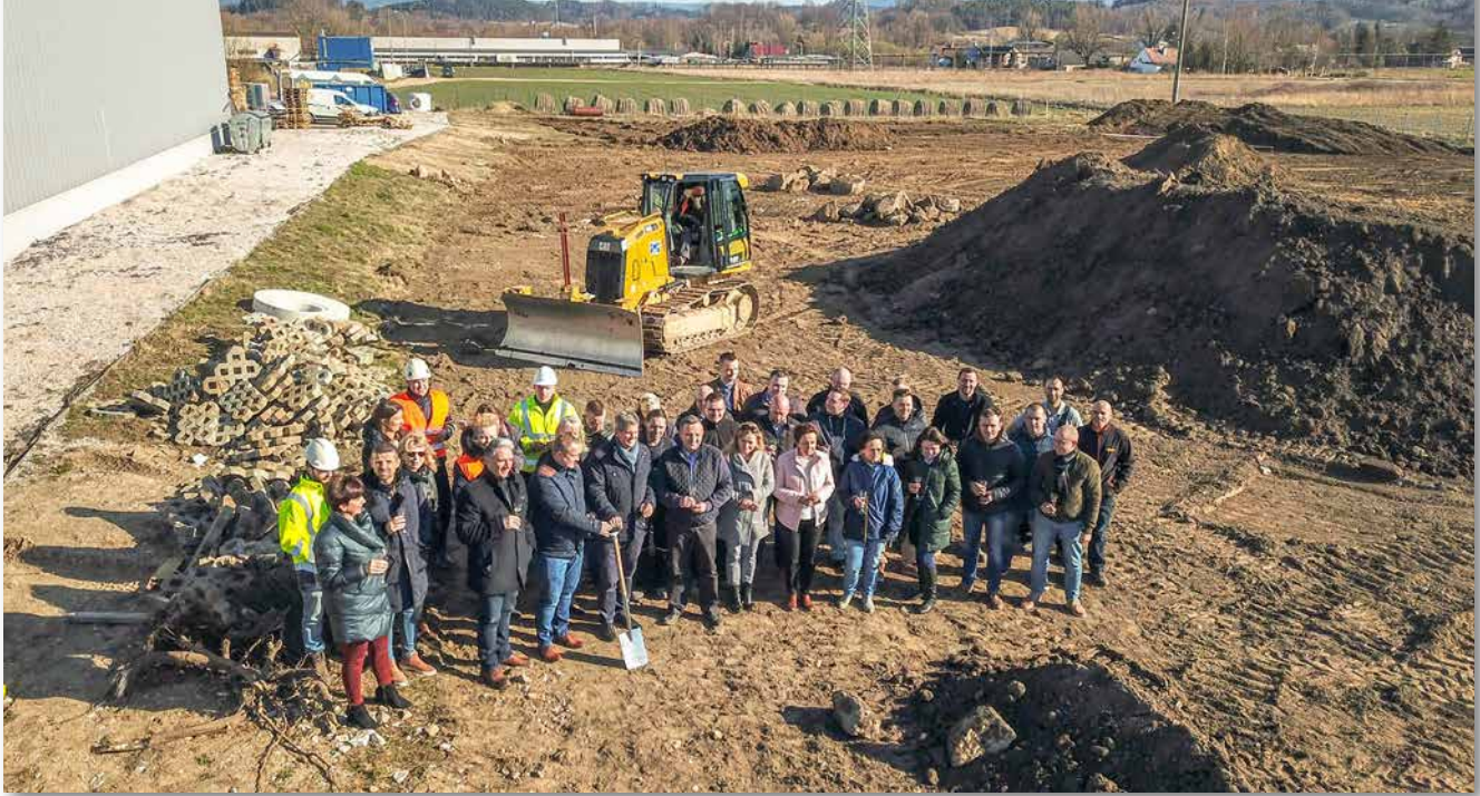
Wkopanie kamienia węgielnego pod budowę nowoczesnego Centrum Logistycznego, rok 2019
