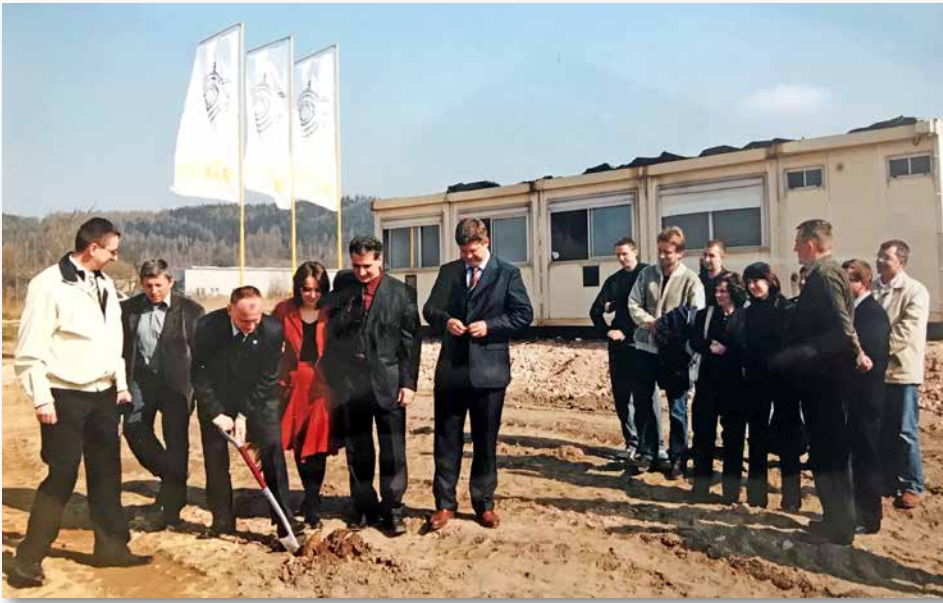
Grundsteinlegung für das Büro- und Lagergebäude von Sikla Polska in der Spódzielcza Straße 55, 2007
