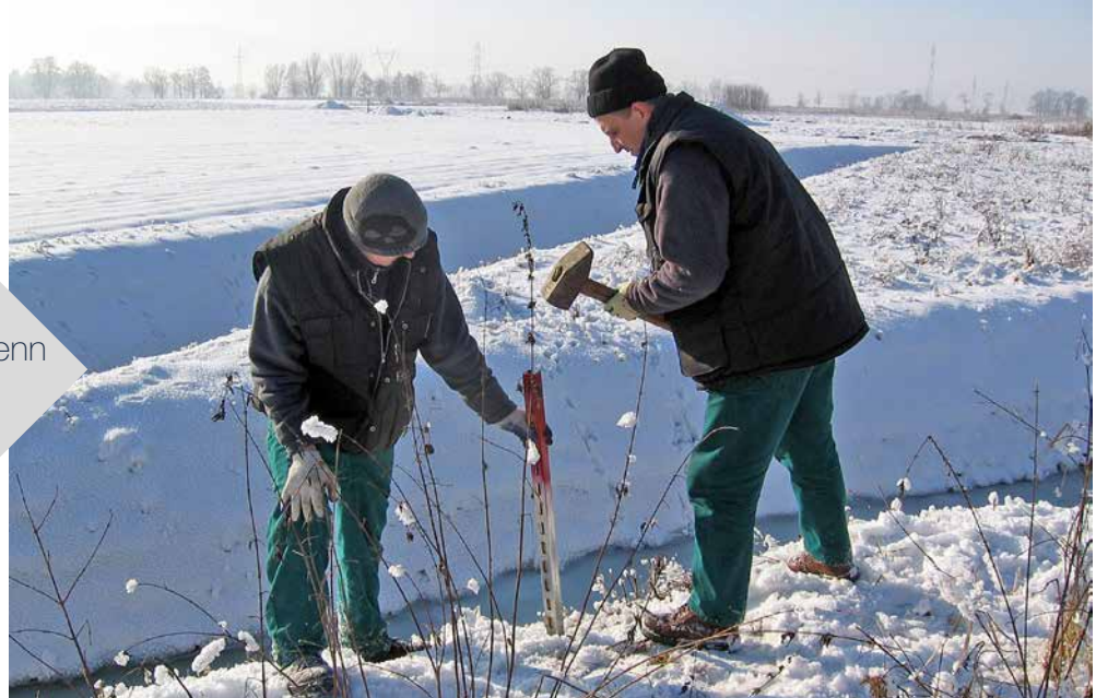
Einschlagen von Pfählen zur Markierung der Grundstücksgrenze nach dem Kauf des Grundstücks an der Spóldzielcza-Straße
