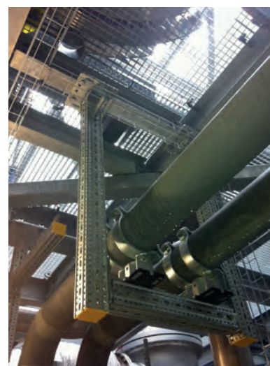
Zdjęcie archiwalne: Modułowy system skręcany siFramo do szybkiego montażu wtórnej konstrukcji stalowej
