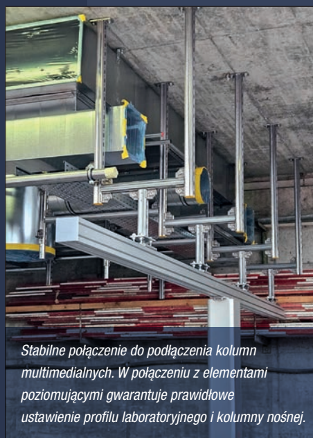
3-wymiarowa kratownica mocująca do obszarów o dużej gęstości instalacji i wysokich wymaganiach w zakresie elastyczności.
